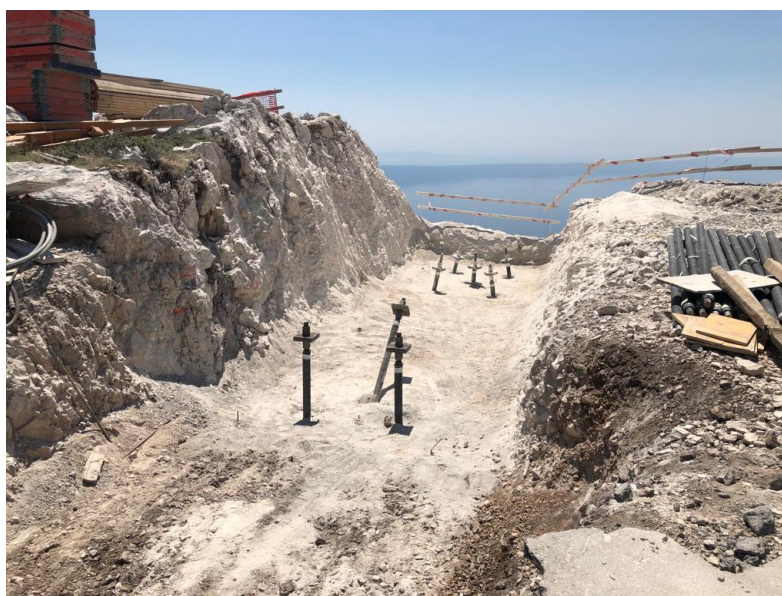
Slika 13: Izvedba geotehničkih sidara ispod temelja
