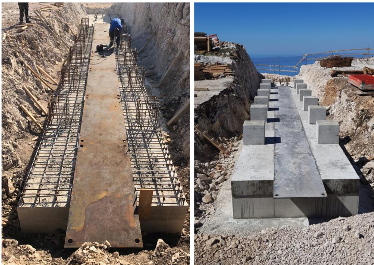
Slika 10: Staza za potiskivanje konstrukcije
