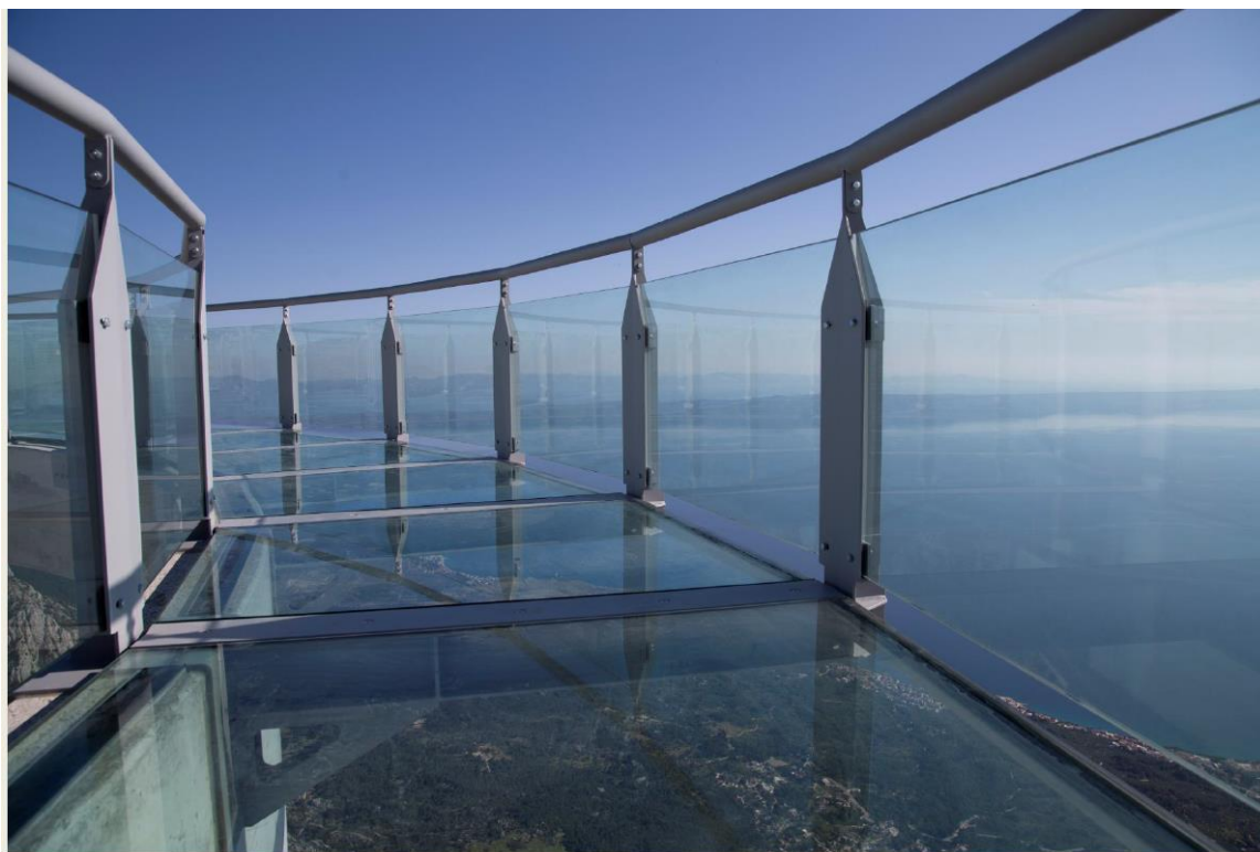
Slika 9: Stakleni pod i ograda – izvedeno stanje
