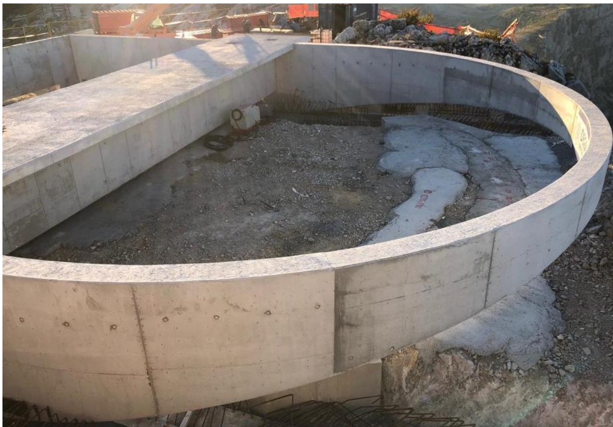
Slika 3: Konstrukcija luka tijekom izvedbe
