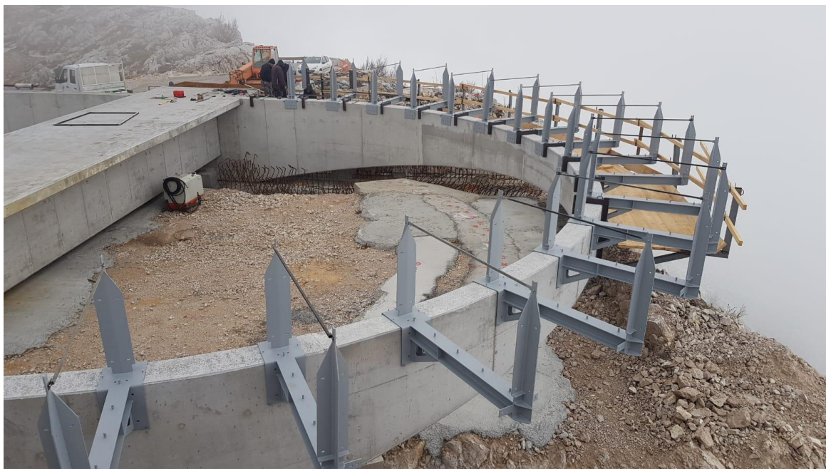
Slika 8: Čelične konzole tijekom izvedbe
