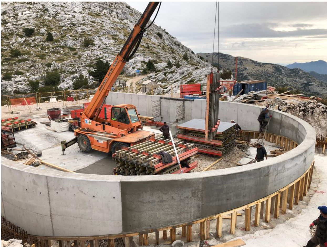
Slika 15: Izvedba betonskog dijela konstrukcije u početnom položaju za potiskivanje
