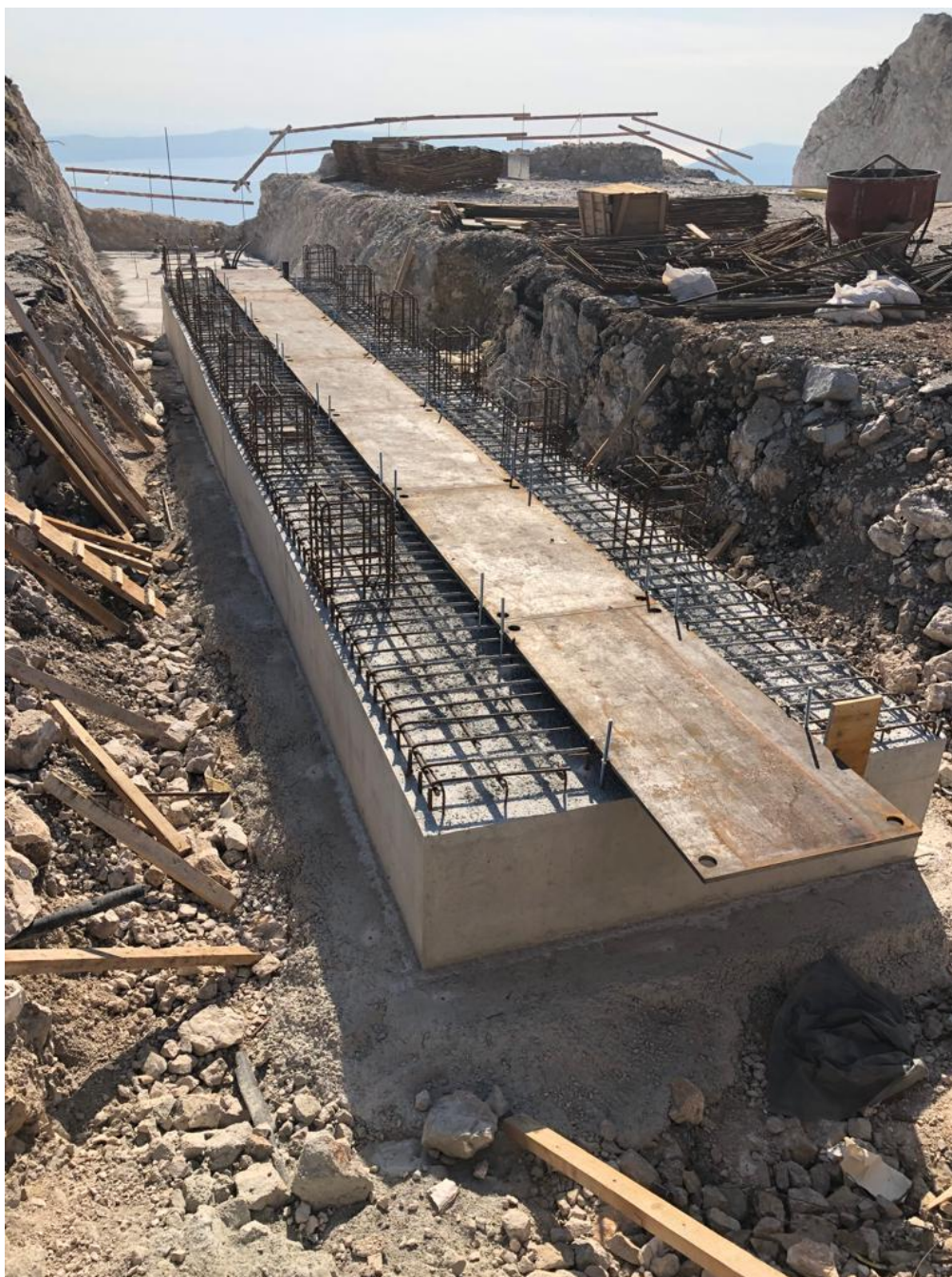
Slika 14: Izvedba temelja i vodilica
